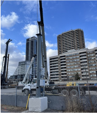
Installation d'une base gravitationnelle
